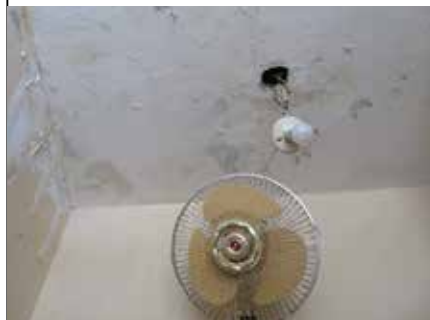
A loose fixture on a ceiling. Una lámpara suelta en el techo.
